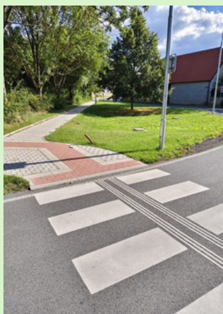
Chodník v ul. Hájecká s retenční nádrží
