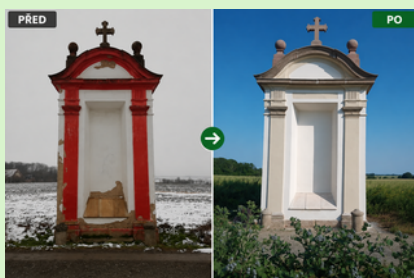
Kaple č. 20 (stav před a po rekonstrukci)
