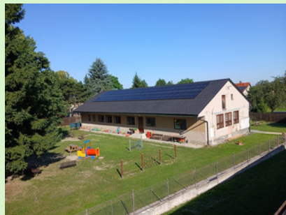
Fotovoltaická elektrárna na MŠ
