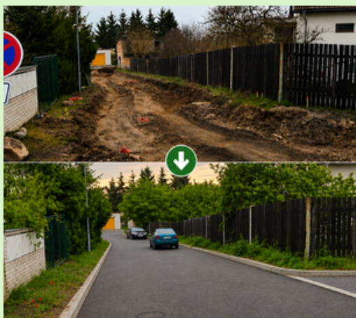
Ulice Na Vyhliďce (v průběhu prací a po nich)
